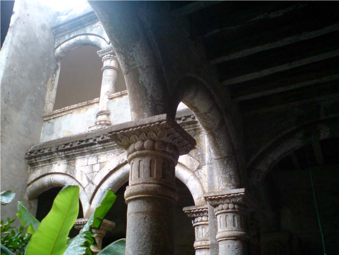
Si existe un claustro hermoso en la arquitectura realizada en el siglo XVI por la orden de San Agustín es este; contando este con unas excelentes proporciones. Se puede observar uno de los cuatro contrafuertes que en su momento se le colocaron previendo algún daño; esto fue cuando se le colocó la cubierta de cal y canto al templo.
