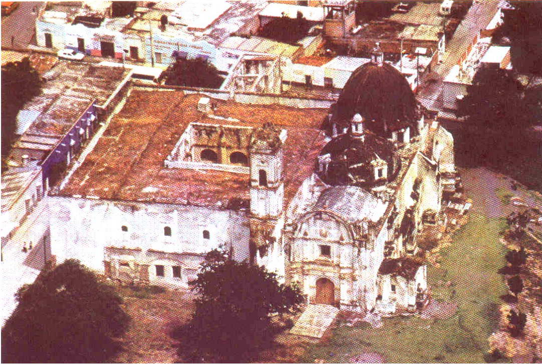
Vista aérea del conjunto conventual de Jonacatepec, en donde se pueden apreciar los diferentes agregados a los cuales se ha visto sujeto. A) El portal fue tapiado y convertido en capilla, B) La primera cúpula sin tambor, C) La segunda cúpula esta con un tambor octagonal, D) Las capillas o monumentos funerarios que están ubicados en la parte exterior del muro de la epístola. Así mismo se puede observar que la mancha urbana esta absorbiendo al monumento (el paño norte del convento esta sobre la calle del poblado, algo similar pasa en la fachada poniente).
