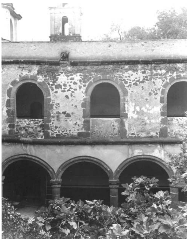
Documento fotográfico tomado del claustro alto en el cual podemos observar el trabajo de cantería, siendo este de una factura bastante sencilla, tal vez debido al material empleado para su elaboración (piedra basáltica).
