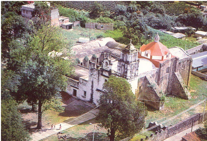
Foto aérea del estado en que se encontraba el conjunto conventual de Tlalnepantla, antes de realizarse diferentes trabajos en el atrio.
