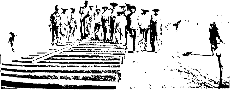
26.- Ferrocarril Sonora- Baja California, tendido de Vía en el desierto, 1937. (Foto: A.G.N.)
