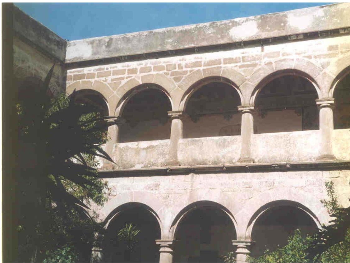
Fig. 30) Claustro del convento de Tepepulco. (fotografía Juan Pedro Rivera)
