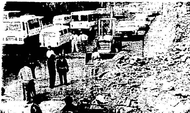
TREMENDO congestionamiento de tránsito fue provocado al desgajarse un cerro a la altura del kilómetro 14 de la carretera México-Pachuca. Las lluvias reblandecieron el talud. (Foto de Francisco León)
