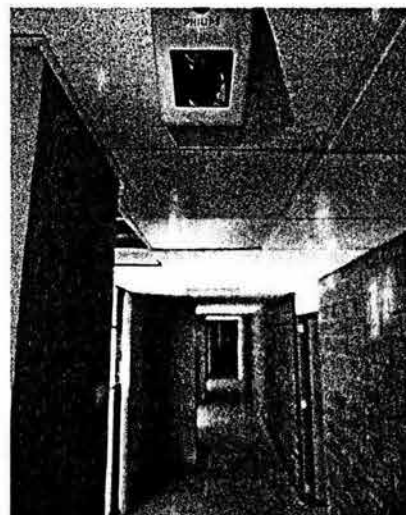
Circuito cerrado en la administración.
