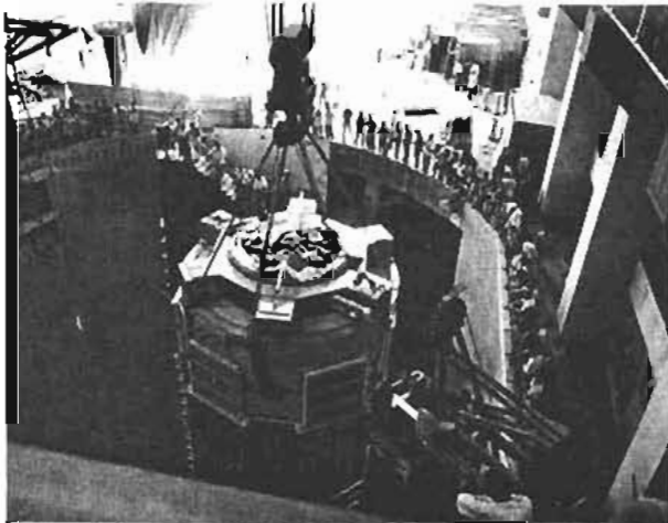
Instalación de un generador
