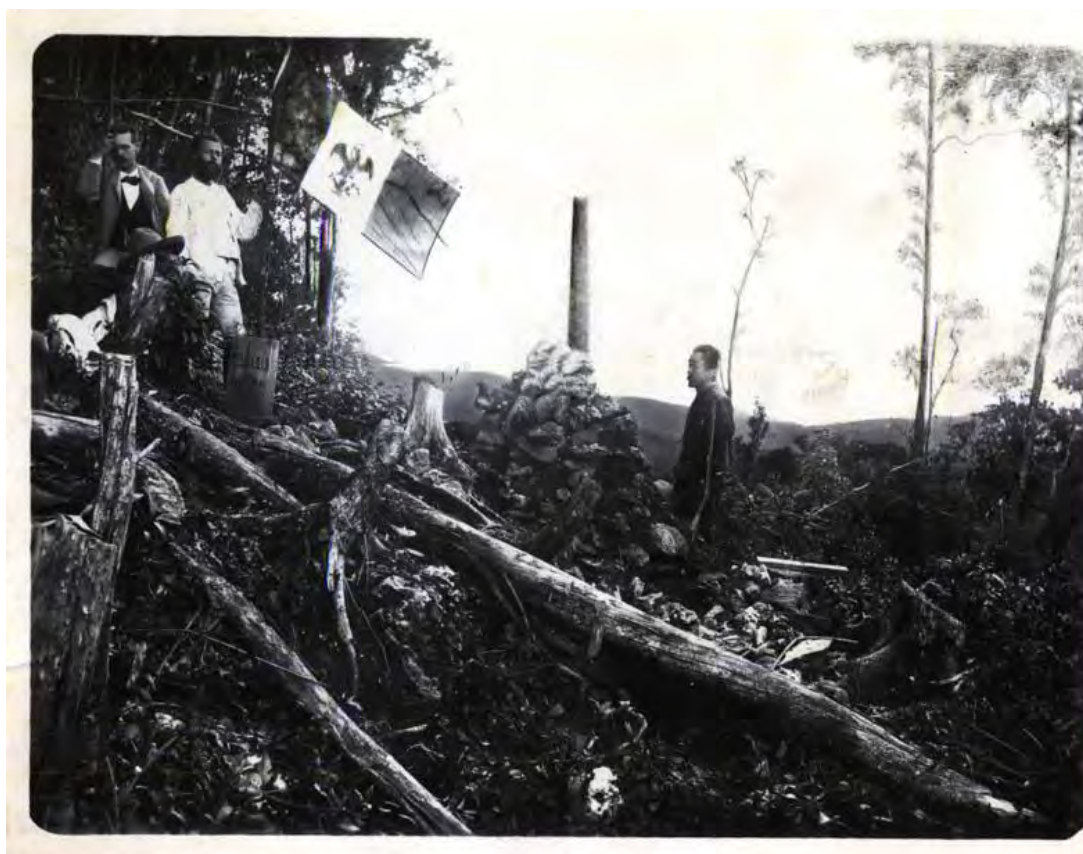
Figura 20. Paralelo del vértice de Santiago. Posiciones relativas de los dos postes del trazo de la comisión mexicana y de los postes señalados con un mojón de piedra por el jefe de la comisión guatemalteca como punto en que debería construirse el monumento. Vista del no. 2 ½ de la comisión mexicana tomada de este a oeste.
