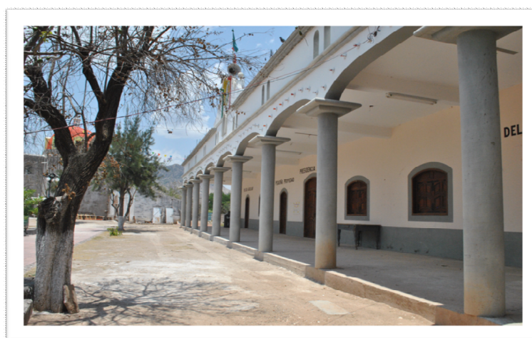
Edificio de la presidencia auxiliar de El Rosario, 2010.
