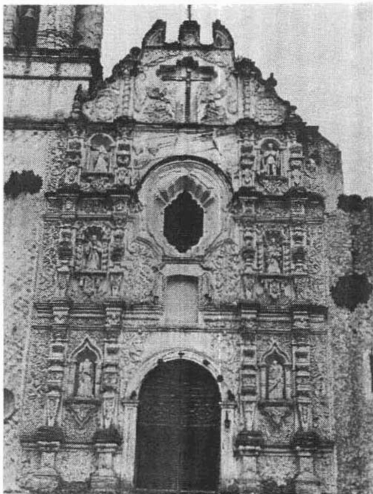
Fotografía de la fachada de Tancoyol.
