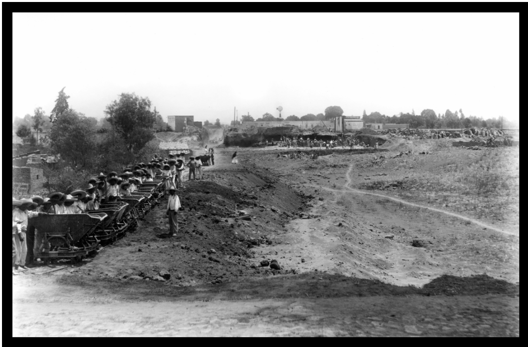
17SCO62. Ignacio Avilez-SCOP, “Construcción de la Avenida de los Insurgentes”, 1921-1924. Vista sobre la obra a la altura del Rancho San José o Actipan.
