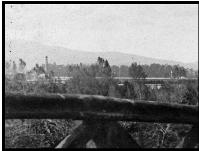
19NCO43. Autor no conocido, “Jóvenes en el Puente de la Morena”, 1900-1905. Ésta imagen es un detalle a la altura del barandal del puente; al fondo se observa claramente una chimenea.
