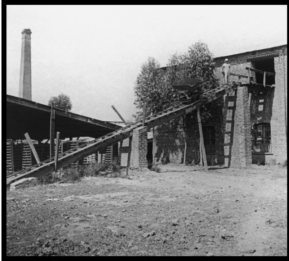
17AVI12. Ignacio Avilez, “Ladrilleras y minas de arena en Mixcoac”, 1920. Transportación del material desde los pudrideros hacia el batidor en La Moderna.
