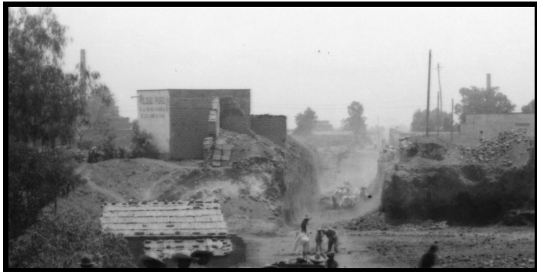
17SCO62. Ignacio Avilez-SCOP, “Construcción de la Avenida de los Insurgentes”, 1921-1924. Detalle. En los extremos laterales de la imagen se alcanzan a ver dos chimeneas.
