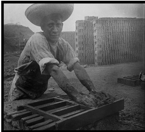
17AVI19. Ignacio Avilez, “Ladrilleras y minas de arena en Mixcoac”, 1920. Haciendo tabiques en La Guadalupeana.
