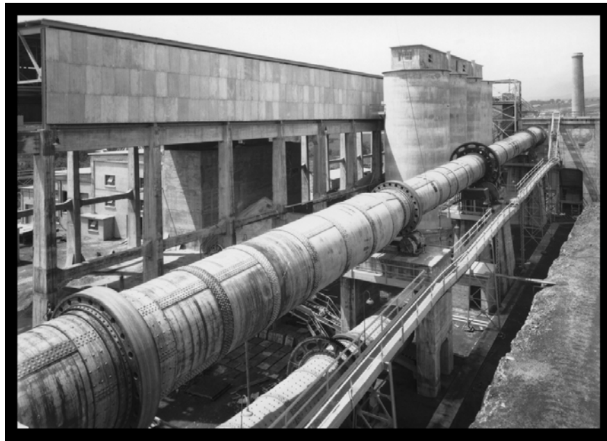
19EDI12. Díaz, Delgado y García, “Cementera La Tolteca”, 1931. Toma de las instalaciones en su lado poniente.
