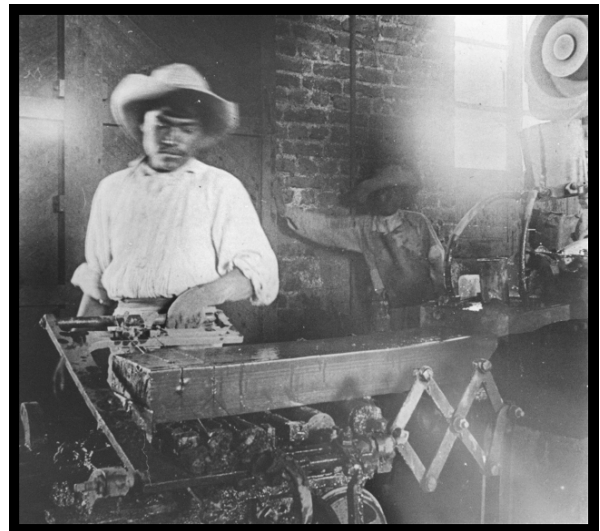
17AVI15. Ignacio Avilez, “Ladrilleras y minas de arena en Mixcoac”, 1920. Elaboración de ladrillos en La Moderna.
