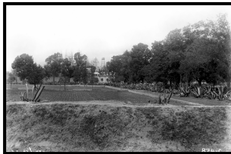
17SCO50. Ignacio Avilez-SCOP, “Construcción de la Avenida de los Insurgentes”, 1921-1924. Tramo en los terrenos de las ladrilleras de San Isidro y Seboruco donde se rellenó.
