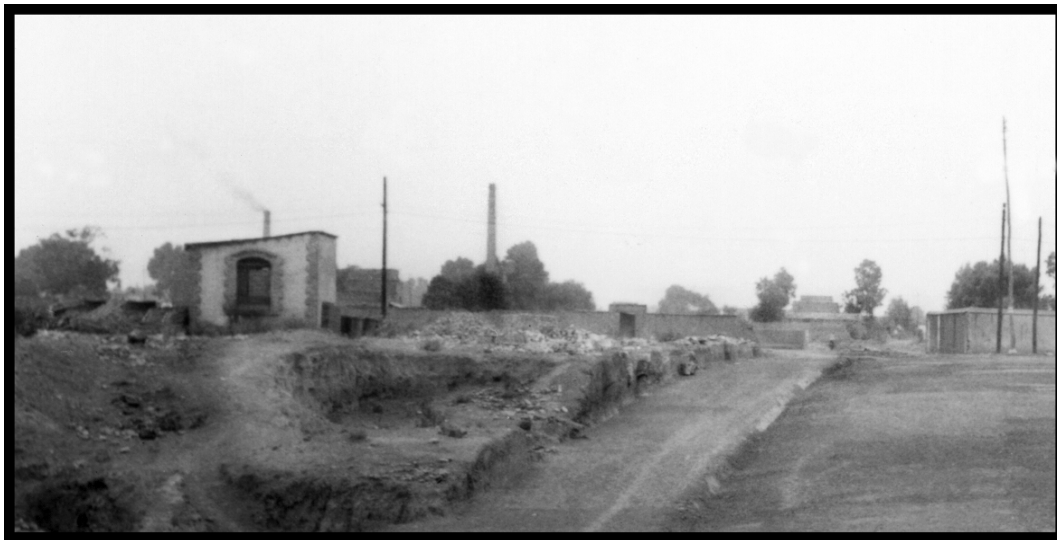
17SCO59. Ignacio Avilez-SCOP, “Construcción de la Avenida de los Insurgentes”, 1921-1924. Detalle. Al fondo aparecen varias chimeneas de las ladrilleras de la zona.
