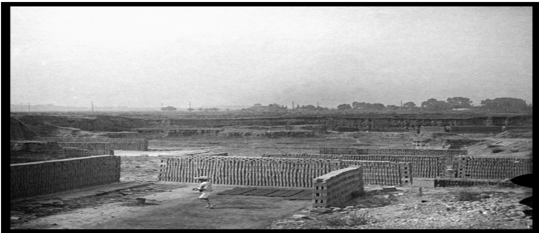
17AVI8. Ignacio Avilez, “Ladrilleras y minas de arena en Mixcoac”, 1920. Elaboración y secado de ladrillos.
