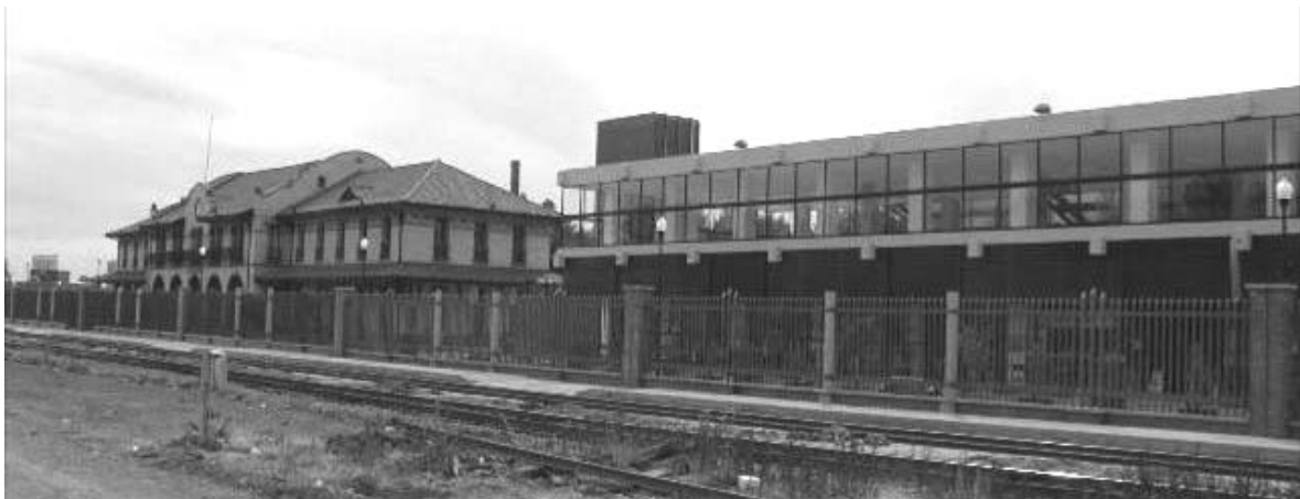
SOP, Cafetería y servicios en el Complejo Tres Centurias , al fondo antigua Terminal del Ferrocarril, ahora Museo Ferrocarrilero , Aguascalientes, 2003. FOTOS: JMAM
