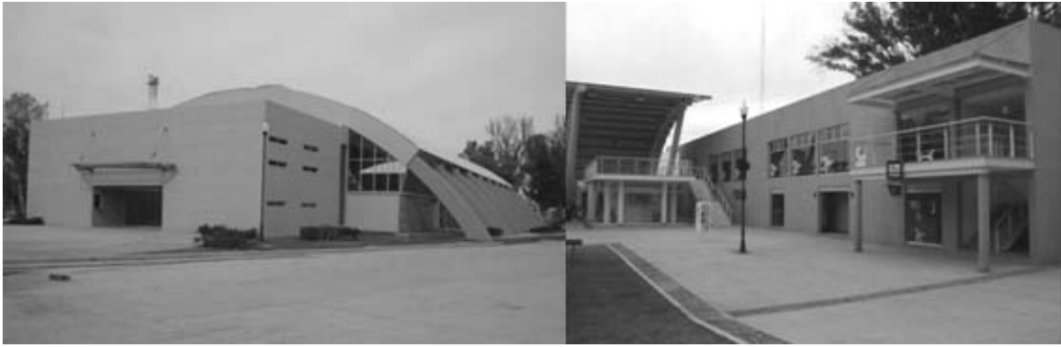
SOP, Remodelación Deportivo Ferrocarrilero , Aguascalientes 2002. FOTOS: JMAM
