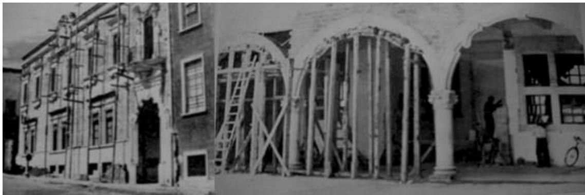
Trabajos de remodelación y ampliación del Palacio de Gobierno FOTOS: AHEA
