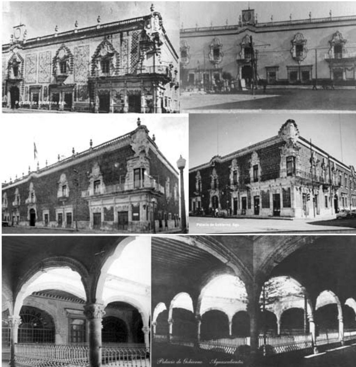
Palacio de Gobierno de Aguascalientes. Diversas etapas de remodelación: FOTO 1 a principios del siglo XX con el aplanado de tipo barroco “aborregado”; FOTO 2, a fines de los años cuarenta sin el aplanado barroco; FOTO 3, c. 1950 recubierto de tezontle rojo, aún con balastrada en el remate superior y sin ampliar ni recortar la fachada poniente; FOTO 4, c. 1958 con el recorte de la fachada y la ampliación del lado poniente por el nuevo segundo patio; Fotos 5 y 6 c. 1950 de la planta alta. FOTOS: AHEA
