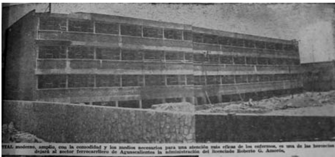
Hospital Ferrocarrilero 1959, En construcción 1956, FOTO: El Sol del Centro 561126
