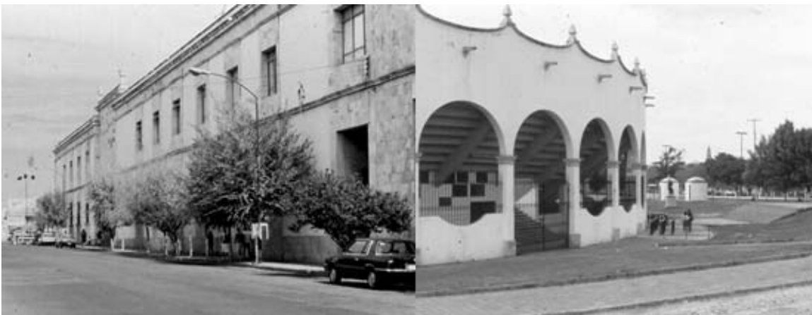
Jaime López Cuellar, Casino de la Feria Aguascalientes y Nueva Plaza de Toros Aguascalientes 1974 FOTOS: JMAM
