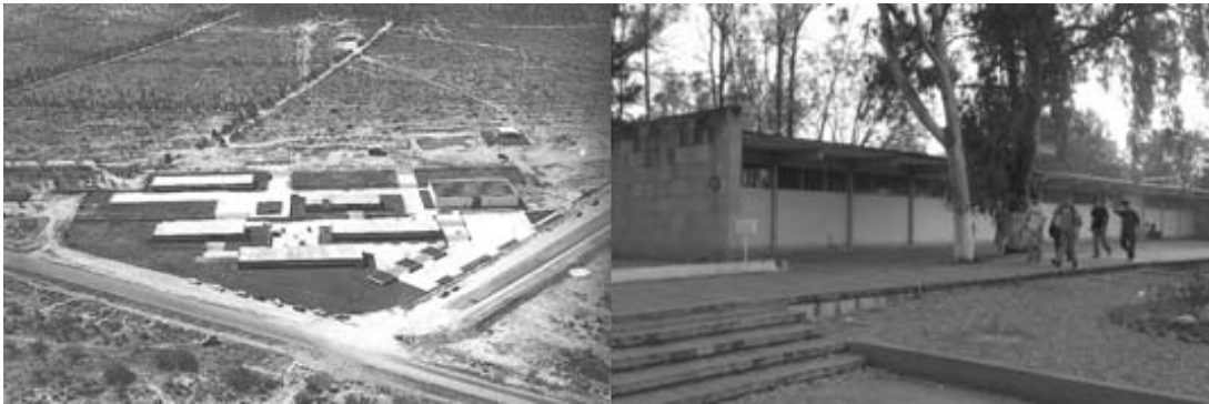
Instituto Tecnológico de Aguascalientes, vista aérea primera etapa 670918; y aula prototipo FOTOS: Archivo y JMAM
