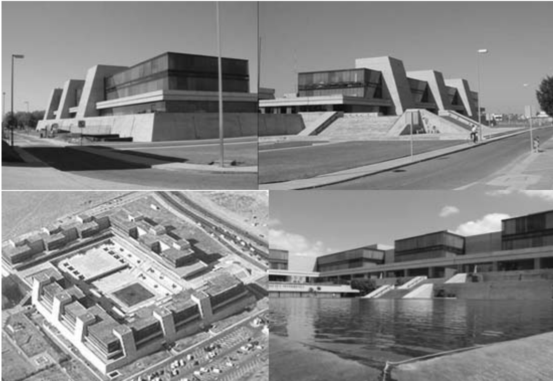
Alejandro Caso Lombardo y Margarita Chávez, Edificio del INEGI , Aguascalientes 1986. FOTOS: Archivo y JMAM
