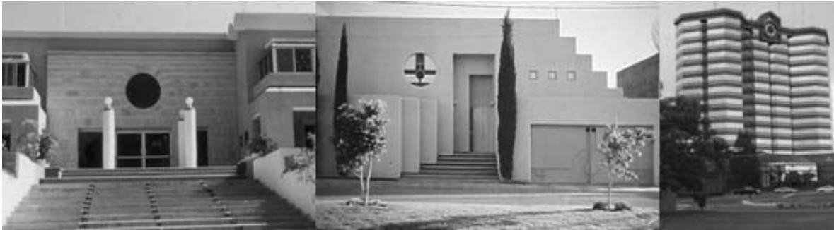
Mario García y Carlos Parga, Club Campestre Aguascalientes 1986. Rafael González y Martín Andrade, Casa Rodríguez , Aguascalientes 1988, José Bassol y Luis Arnal, Torre Bosques , Aguascalientes 1990. FOTOS: JMAM
