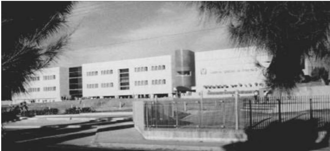
Hospital Regional de Zona No. 2 IMSS, Aguascalientes 1994. FOTO: JMAM
