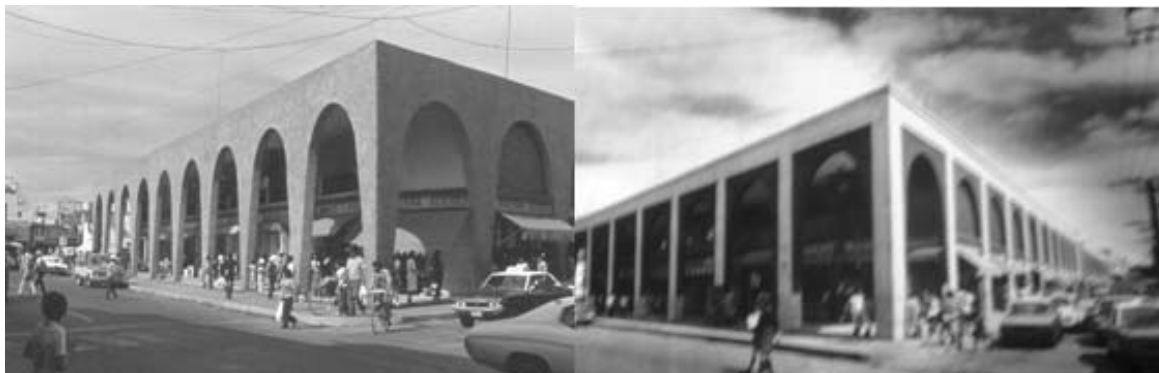
Eduardo Salceda García, Mercado Terán , Aguascalientes, 1983, González y Andrade transformación de fachada, 1986. FOTOS: JMAM
