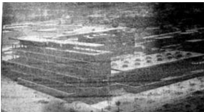
Construcción de Ciudad Universitaria , D.F. 1952, FOTO: El Sol del Centro 520309
