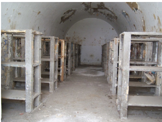
Vista interior de una de las galerías de la fortaleza, en David Guerrero Flores. Op. Cit.
