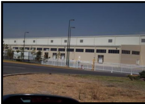
Figura 3.92 Avance de Obras y Ocupación Puerto Interior Silao - León
