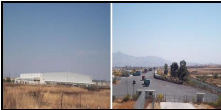
Figura 3.91 Avance de Obras y Ocupación Puerto Interior Silao - León
