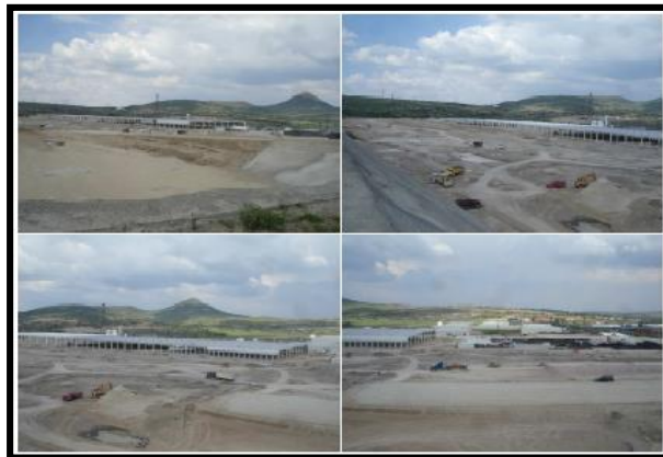
Figura 3.72 Centro de Distribución COSTCO. ab
