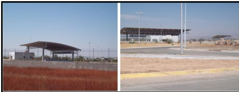
Figura 3.90 Avance de Obras y Ocupación Puerto Interior Silao - León
