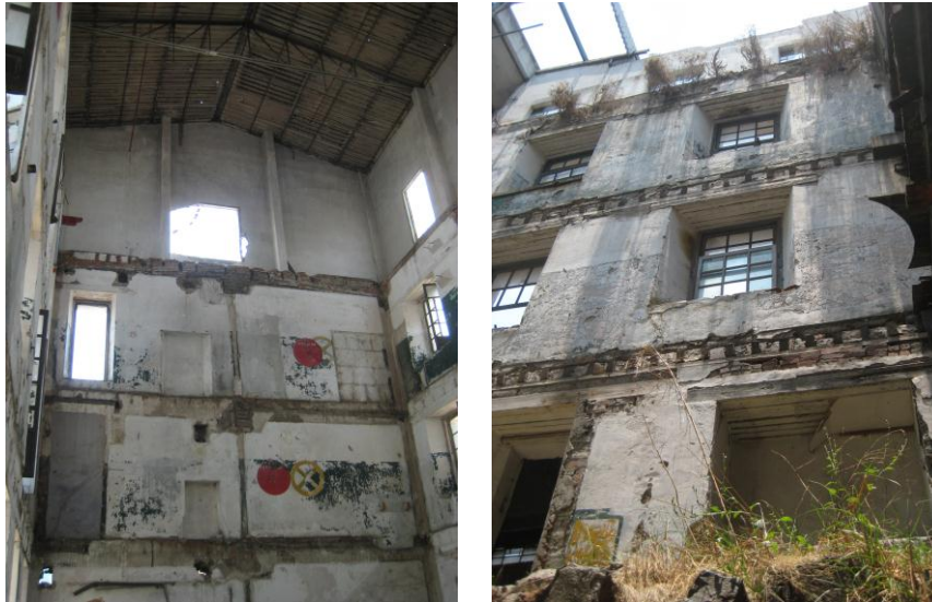
Foto 18 y Foto 19. Detalle de interior, aplanados y pintura a la cal, también presencia de pintura vinílica Fuente: Langarica 2011
