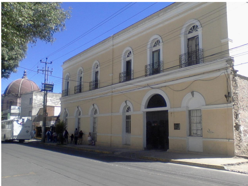
Foto 1. Jabonería Moderna. Fachada de la Jabonería Moderna en el año 2012. A pesar de contar con pintura en buen estado en su fachada, el edificio no se mantiene en uso, deteriorándose poco a poco. Fuente: Langarica 2012
