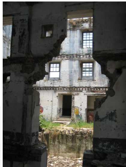
Foto 17. Detalle de uno de los muros expuestos en el que se puede apreciar el sistema constructivo Fuente: Langarica 2011
