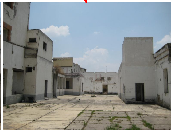
Foto 12. Patio visto desde el edificio del elevador y maquinarias de limpia Fuente: Langarica 2011
