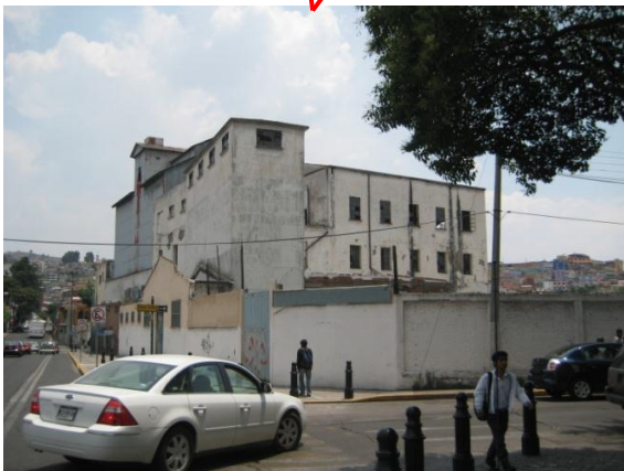
Foto 4. Parte de las fachadas sur y poniente Fuente: Langarica 2011
