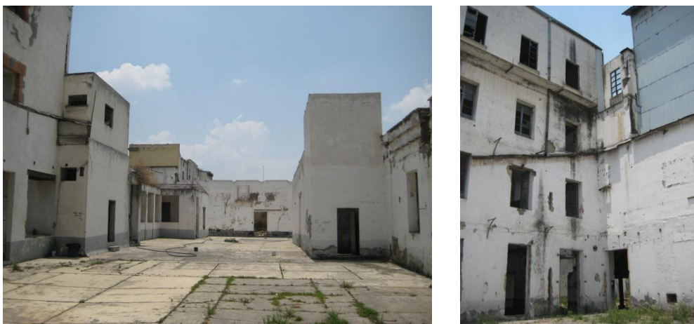
Foto 29 y Foto 30. Estado de completo abandono del Molino de La Unión Fuente: Langarica 2011
