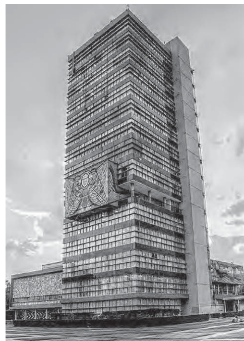
Figura 16.- Torre de Rectoría UNAM – Mario Pani, Enrique del Moral y Salvador Ortega Flores. La Rectoría está construida en un estilo lecorbursiano “enriquecido” formalmente con una estructura de columnas y losas de concreto armado.
