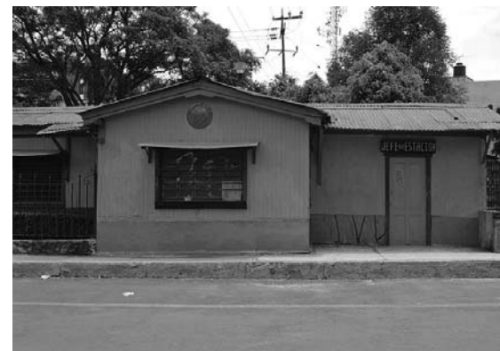
24-Estacion de Ferrocarril
