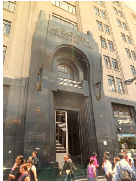
Figura II.10 Detalle de la entrada al edificio La Nacional
