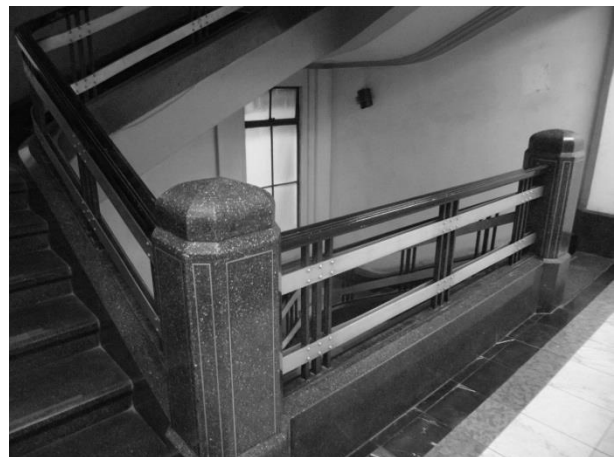
Figura I.37 Detalle de escaleras. Edificio La Nacional. OMG, 2013.
