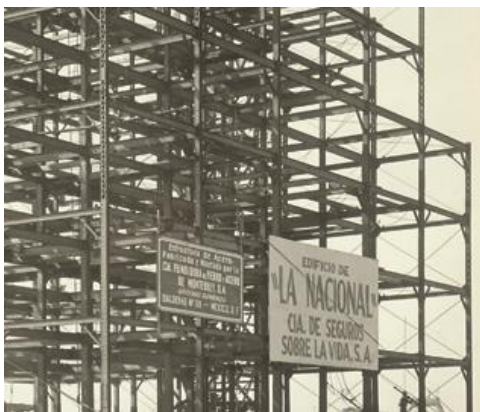
Figura III.2 Detalle de la construcción de la estructura de La Nacional en el que se puede apreciar las tornapuntas usadas en algunas vigas.
