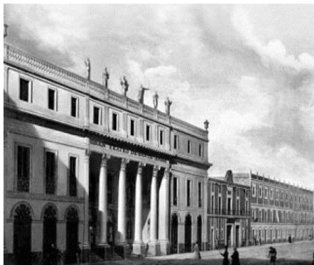
Figura I.18 Antiguo Teatro Nacional (Antes Santa Anna), cimentado con un cajón de arena (demolido).
