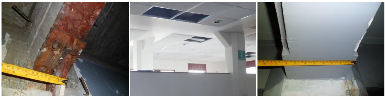
Figura II.5 Medición de elementos estructurales en La Nacional.
