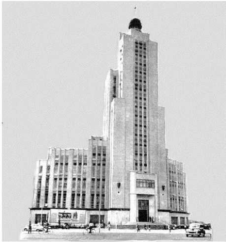
Figura I.21 Edificio de la Lotería Nacional. 1949. Tomado de ref. 40
