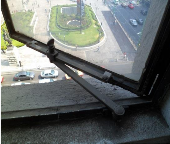
Figura II.15 Detalle del seguro instalado en las ventanas de La Nacional.
