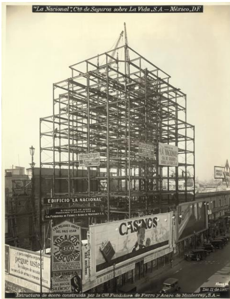
Figura II.6 Imágenes de la estructura de acero del edificio La Nacional el 11 de diciembre de 1931. Fotografías de Guillermo Kahlo, Archivo del Parque Fundidora
