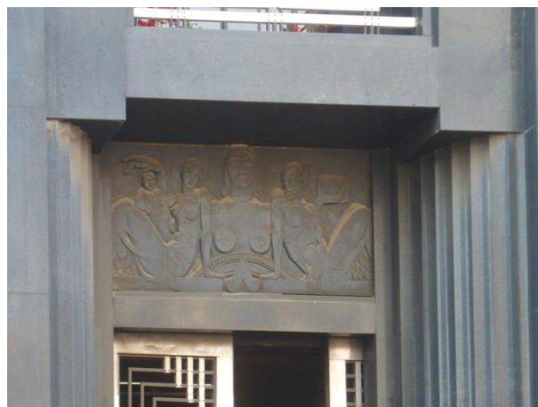
Figura II.13 Detalle del relieve de fachada del edificio La Nacional
