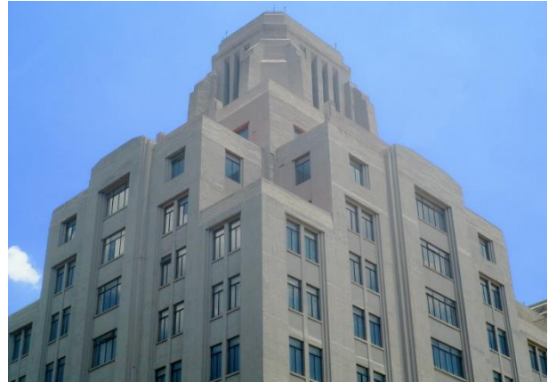
Figura II.11 Detalles de ventanas en fachada y torreta de remate del edificio La Nacional
