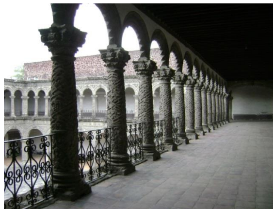
Figura I.7 Claustro del convento de La Merced, construido a finales del siglo XVII. OMG, 2009
