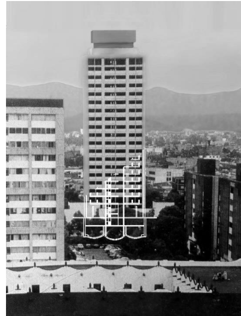
Figura I.19 Uso de bóvedas inversas en la Unidad Habitacional Nonoalco - Tlatelolco (1964)
