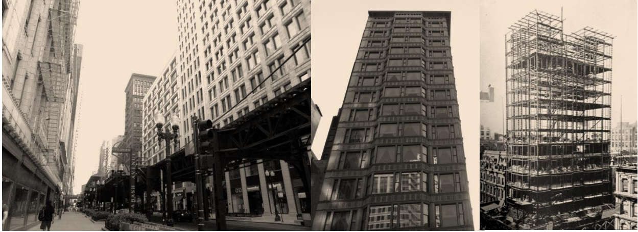
Figura I.24 Edificios de la Escuela de Chicago. A la izquierda, la Av. Wabash con el Loop central. Al centro, el Reliance Building en la esquina de Washington St. y State St., a la derecha, el mismo edificio durante su construcción. 1894. (OMG 2012, Ref. 44)
