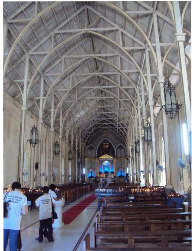
El interior del templo combina la estructura metálica con la mampostería. Foto de autor.
