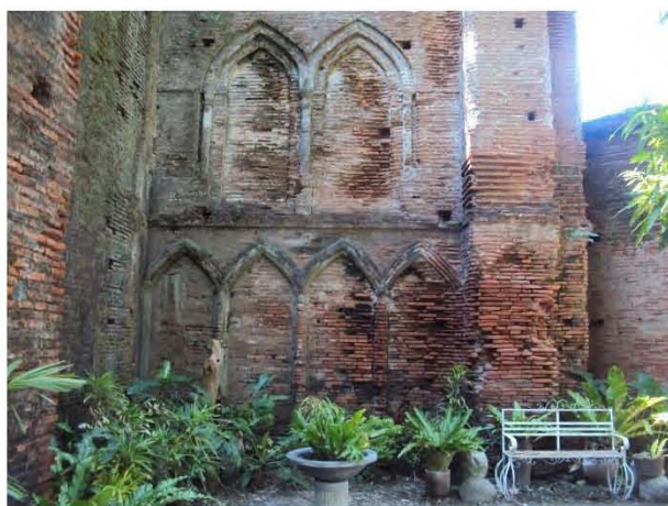
Detalle del trabajo de tabique en muros. Foto de autor.
