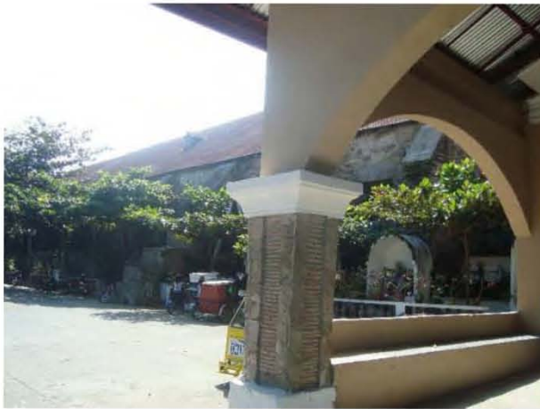
Muro lateral con contrafuertes. Foto de autor.
