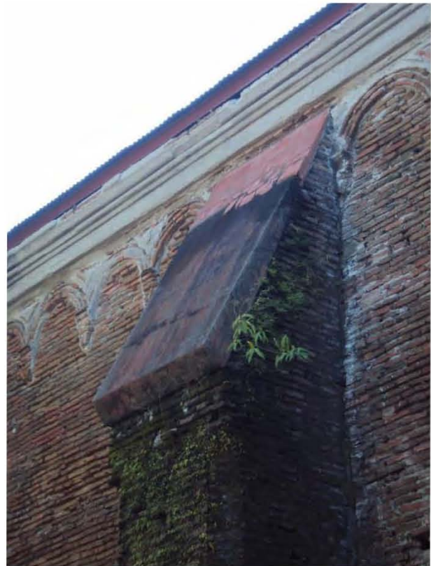
El uso de tabique está presente en la fábrica de muros, contrafuertes y ornamentaciones del templo. Foto de autor.
