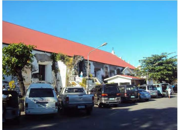
Muro lateral reforzado con contrafuertes. Foto de autor.
