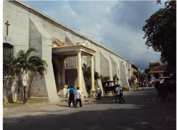
El refuerzo de contrafuertes aparece en los muros laterales. Foto de autor.
