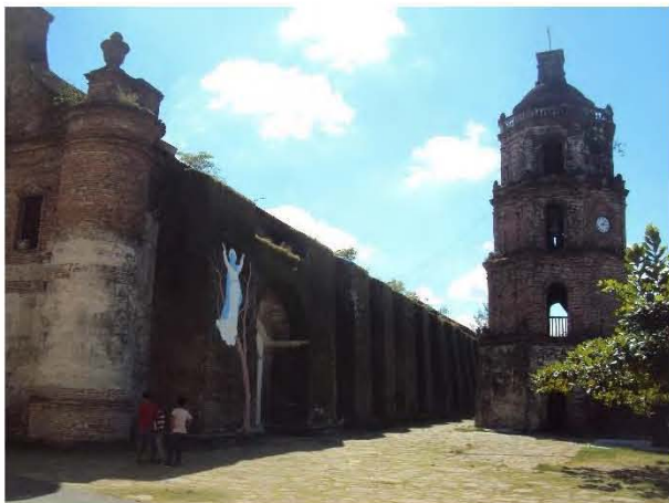
Los muros son reforzados con contrafuertes, la torre campanario se desplanta exenta al templo. Foto de autor.
