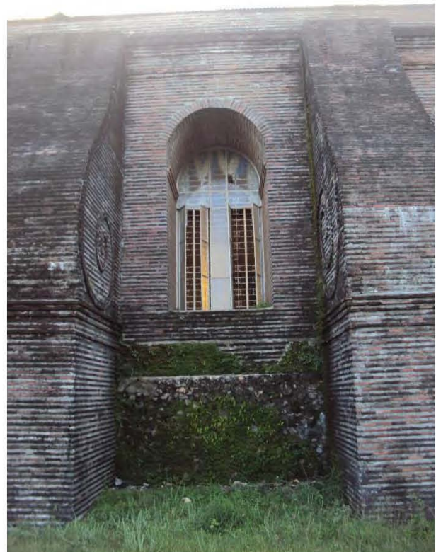
El intersticio entre contrafuertes da cabida a ventanas. Foto de autor.
