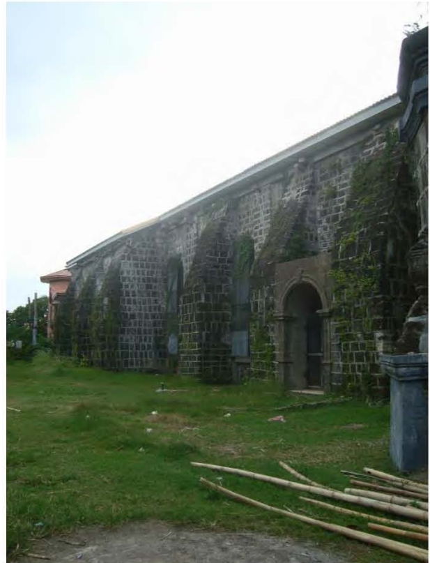
Los muros laterales son reforzados con contrafuertes. Foto de autor.
