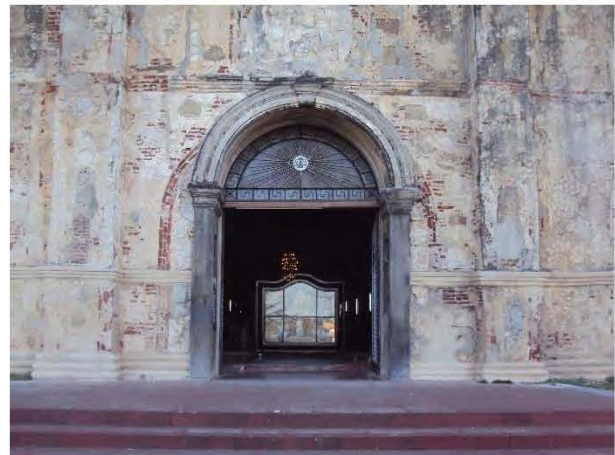
Detalle del acceso al templo, se puede apreciar una etapa previa con un arco mas ancho. Foto de autor.
