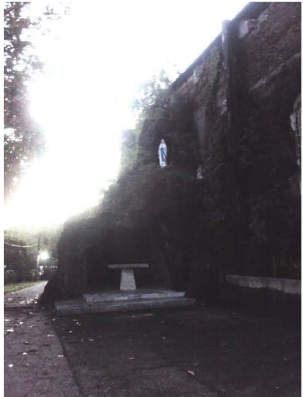
Muro lateral con contrafuertes y escalinata, la cual ha sido adaptada para culto al exterior. Foto de autor.
