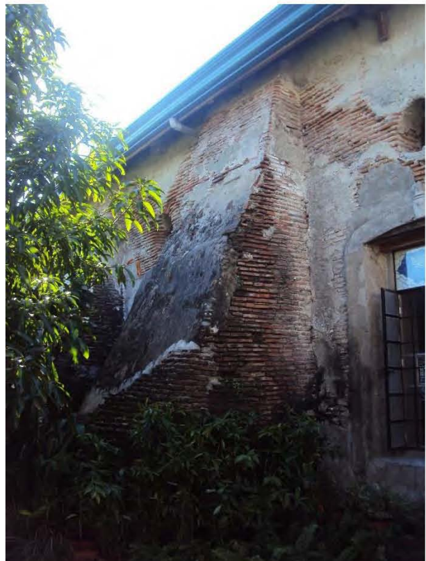
Detalle de contrafuerte y muro construido con tabique. Foto de autor.
