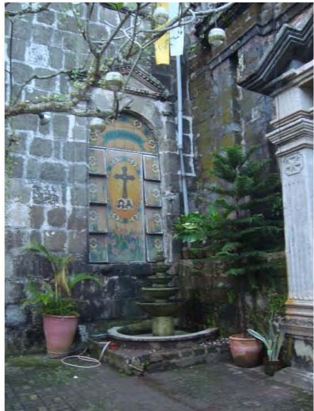
Los muros de piedra careada dan soporte a la estructura del templo. Foto de autor
