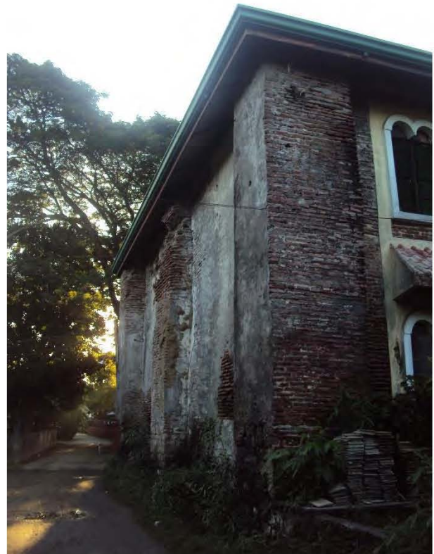
En el ábside aparece un contrafuerte que no cumple ninguna función estructural. Foto de autor.
