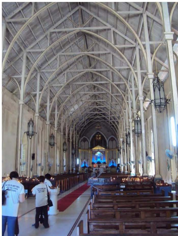
El interior del templo combina la estructura metálica con la mampostería. Foto de autor.
