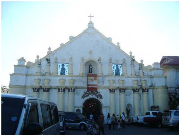
Fachada de la catedral de San Guillermo en Laoag. Foto de autor.
