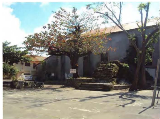
Muro lateral con ruinas de escalinata lateral. Foto de autor.
