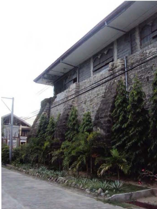
Los contrafuertes aparecen como refuerzos de baja altura por lo que no representan un apoyo estructural. Foto de autor.
