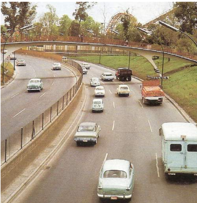
Figura 10. Primer tramo del anillo periférico. Foto: 30 años del metro
