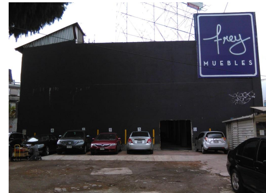
Ilustración 13 Vista interior - Acceso de estacionamiento, predio Muebles Frey
