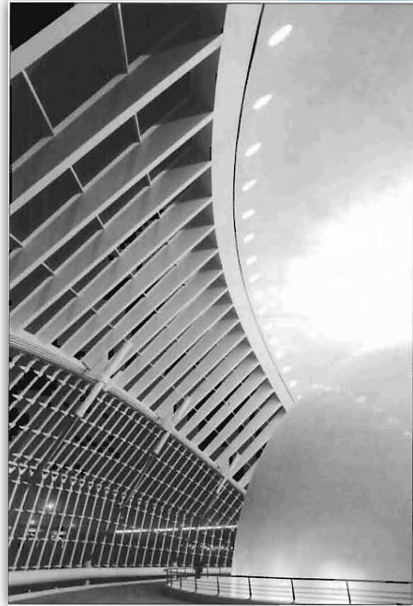
Imagen VIII.1.19 L'Hemisfèric. Detalle de la cubierta ovoide Fuente: L'Hemisfèric: una ventana al mundo.
