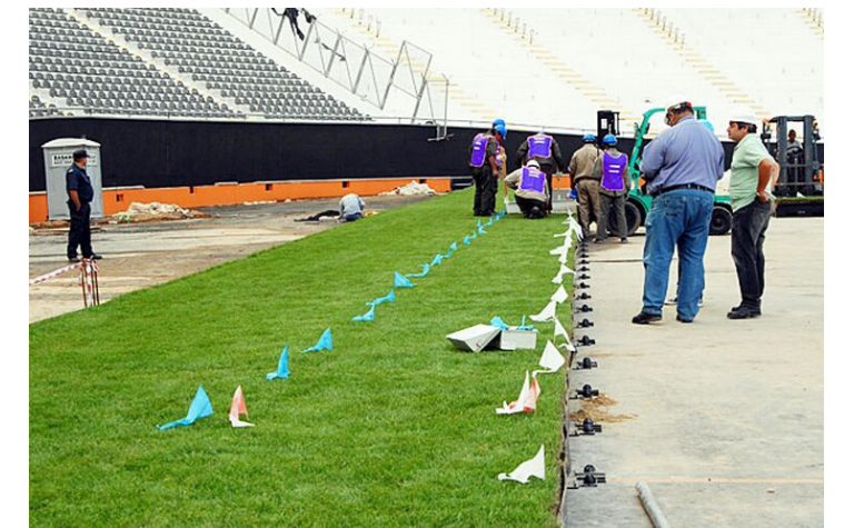
Imagen 85 Fotografía de colocación de pasto en la cancha del Estadio. Imagen obtenida de página oficial
