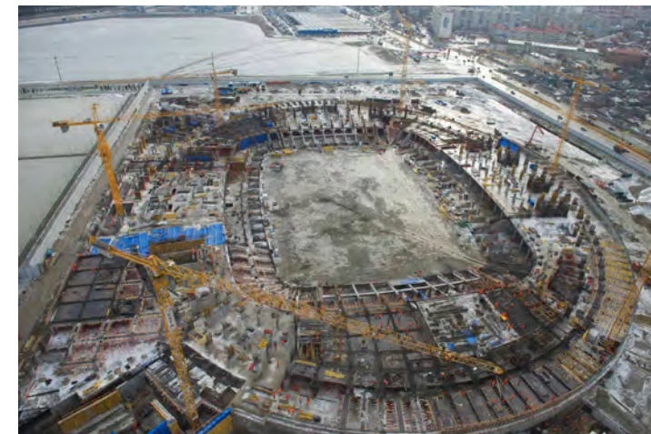
Imagen 102 Foto de proceso de construcción del Estadio. Imagen obtenida de página oficial
