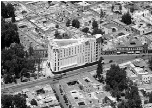
Vista aérea edificio Ermita. Foto: Fundación ICA.
