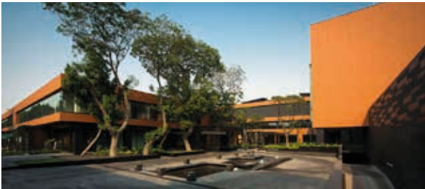
Centro corporativo Coyoacán.
