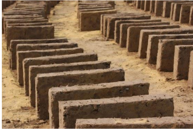
Ilustración 21. Secado del adobe. Imagen tomada de la web para fines académicos.
