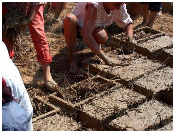
Ilustración 20. Moldeado del adobe. Imagen tomada de la web para fines académicos.
