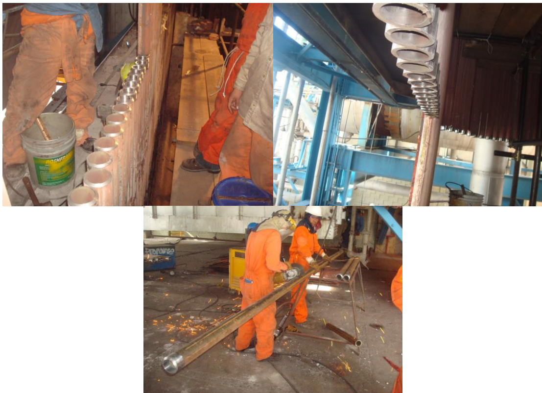
Figura 5.18. Se biselan los elementos.
