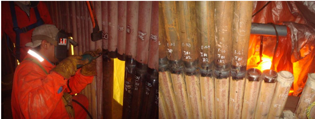
Figura 5.7. Soldadura de elementos.
