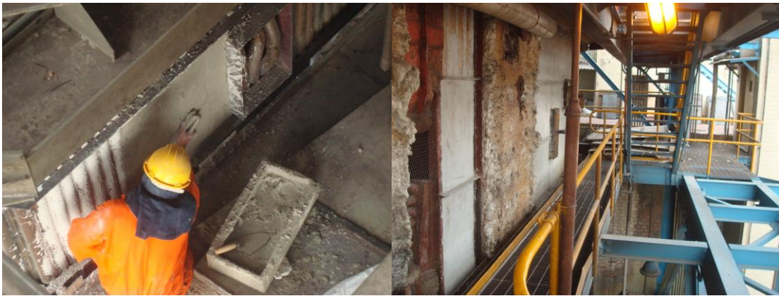
Figura 5.12. Aplicación de cemento.
