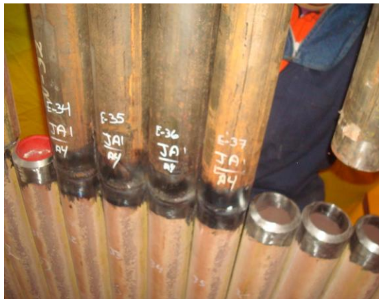
Figura 5.3. Soldadura de los elementos.
