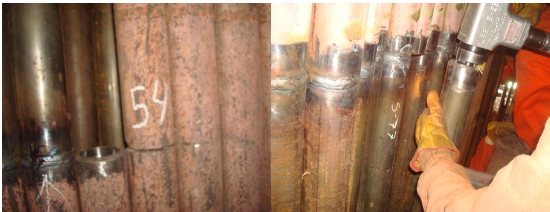
Figura 5.20. Bisel y soldadura de elementos.
