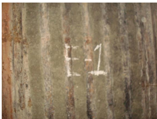
Figura 5.47. Aplicación de cemento refractario.
