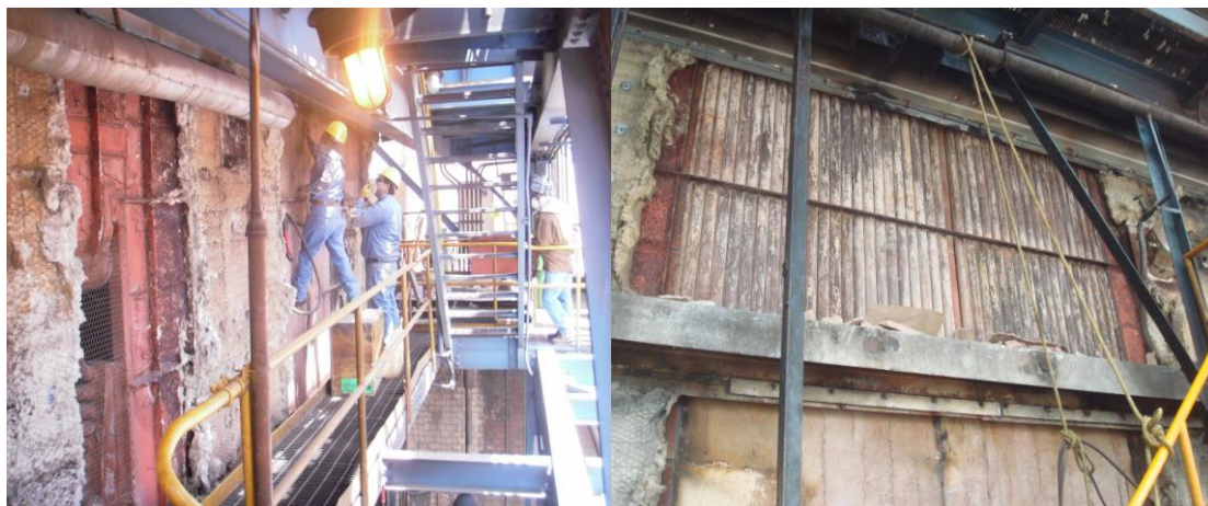
Figura 5. Retiro de colcha de lana mineral y sking casing.
