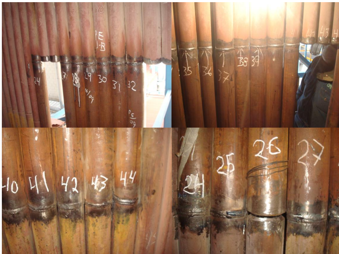
Figura 5.40. Soldadura de elementos.
