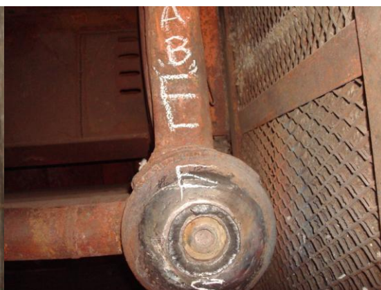
Figura 5.48. Colocación de registros de mano.
