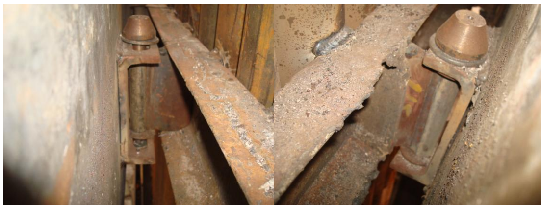
Figura 5.10. Reparación de la viga de sujeción.
