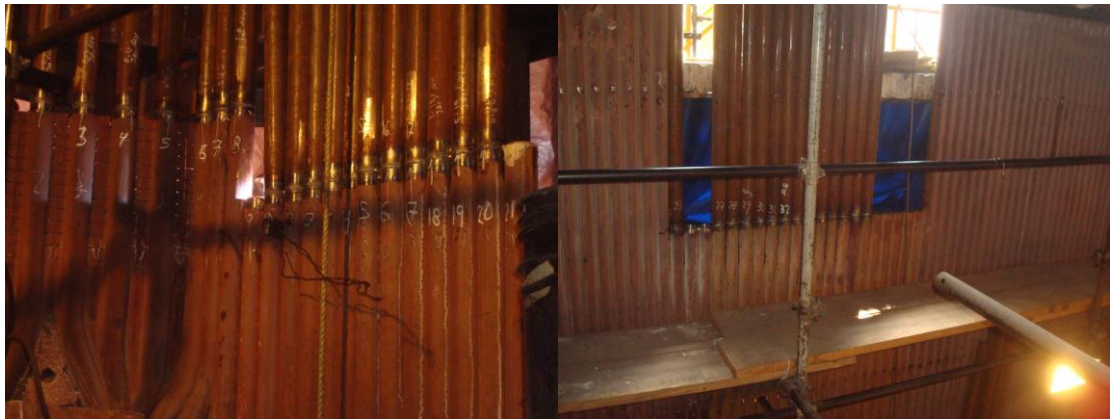
Figura 5.5. Soldadura de elementos.
