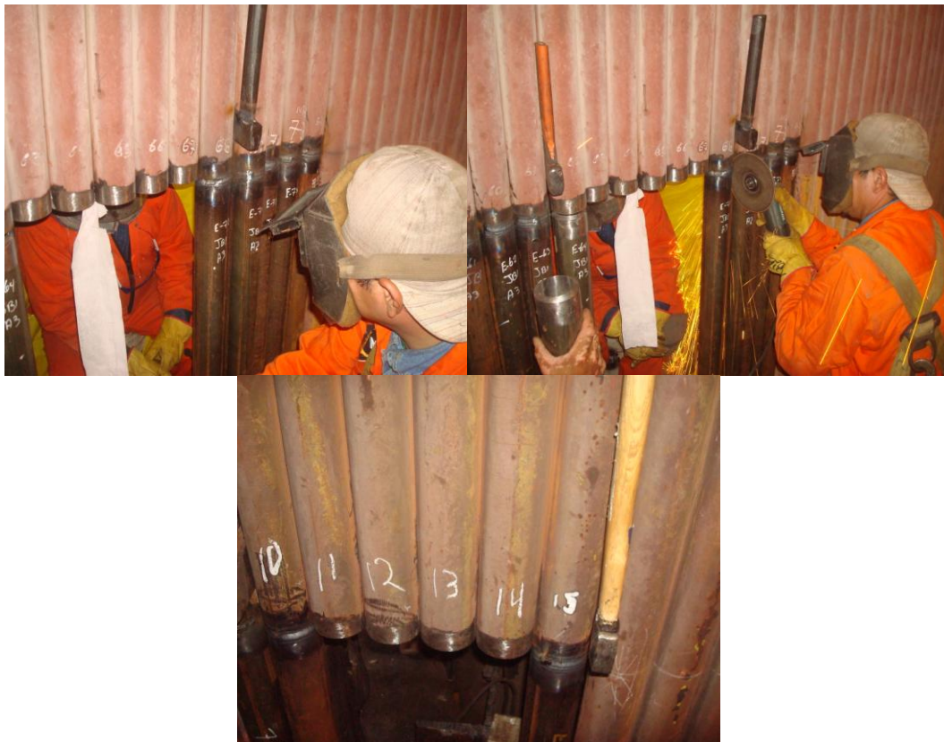
Figura 5.8. Soldadura de elementos
