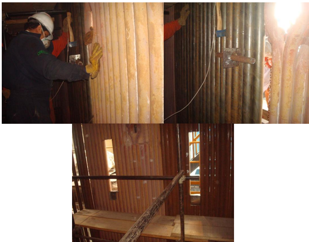
Figura 5.33. Colocación de puertos de adición de químicos.
