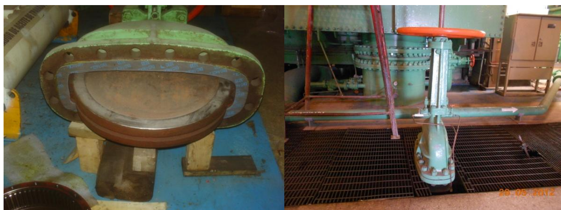
Figura 4.19. Revisión y colocación de la válvula.
