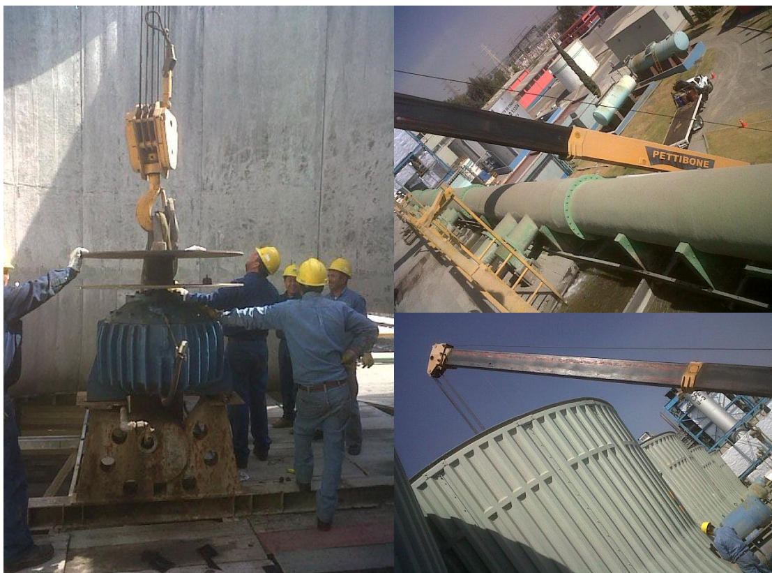
Figura 6.1. Mantenimiento correctivo a torre de enfriamiento.
