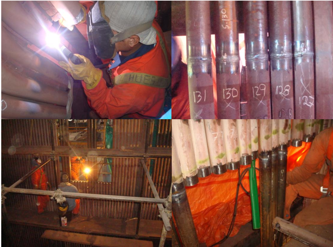
Figura 5.19. Soldadura de elementos.
