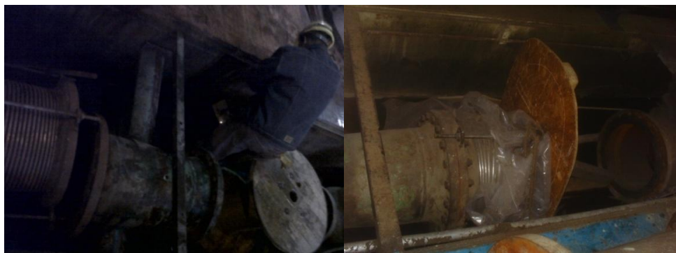
Figura 4.22. Cambio de la junta de expansión con fuelles de acero inoxidable B.E.C.
