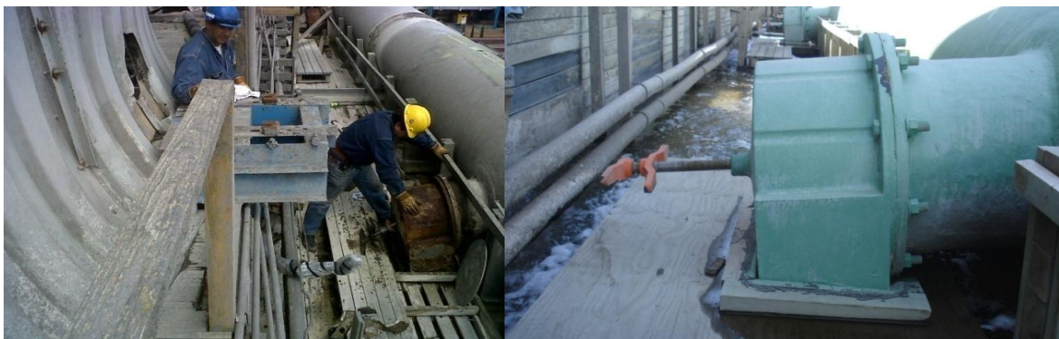
Figura 4.29. Mantenimiento de las válvulas de agua de circulación.
