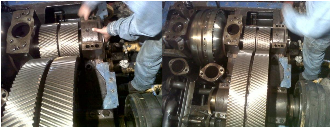
Figura 4.5. Retiro de los componentes del variador.
