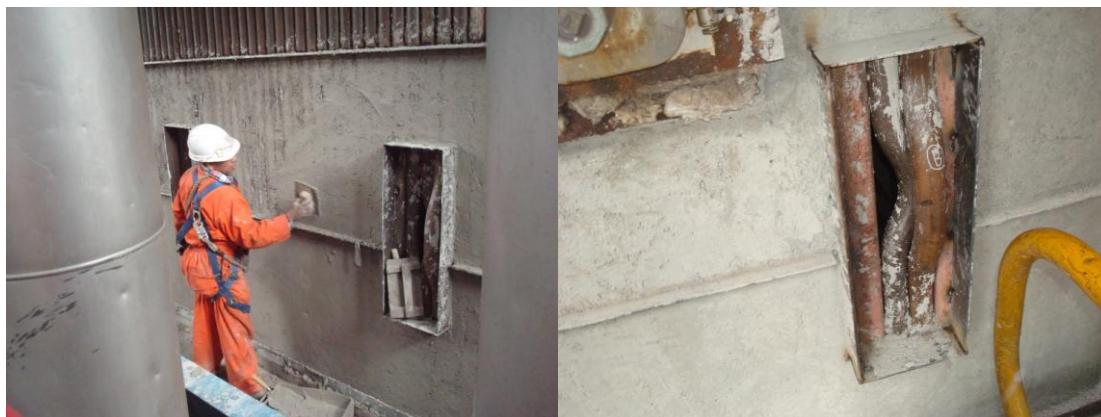
Figura 5.43. Colocación de de cajas para puertos de adición de químicos y pirometría.
