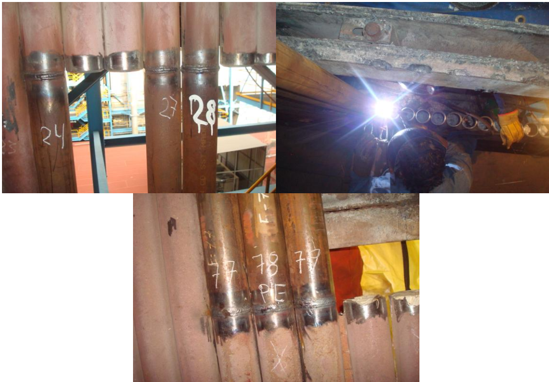
Figura 5.39. Soldadura de elementos.
