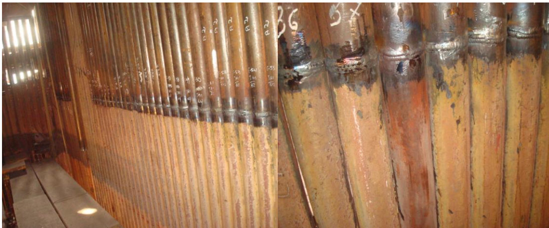
Figura 5.21. Soldadura de elementos.
