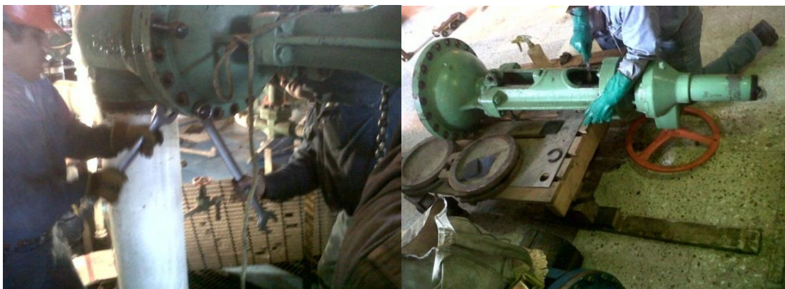
Figura 4.20. Mantenimiento a las válvulas de descarga de las B.E.C.
