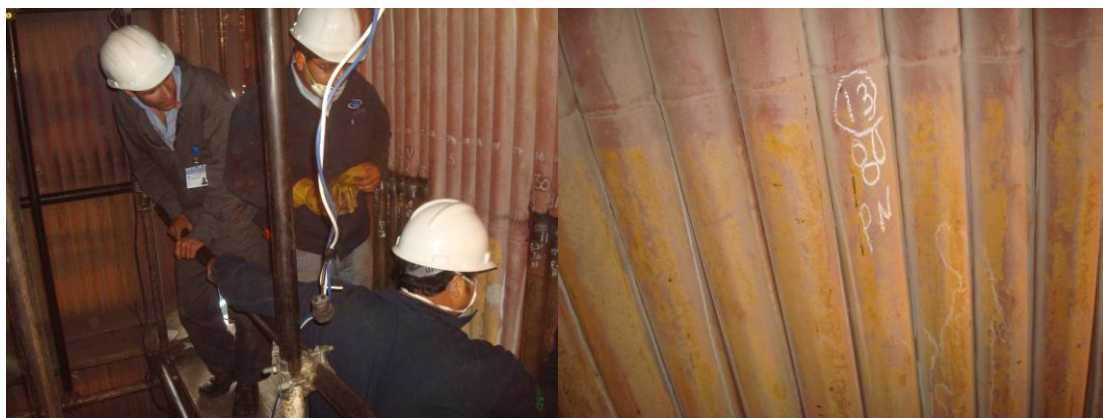
Figura 5.9. Identificación de los puertos de adición de químicos.
