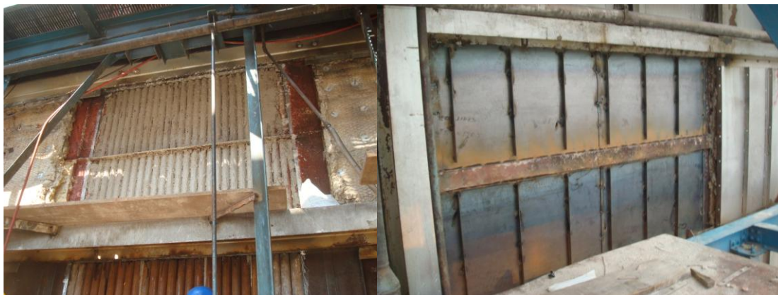
Figura 5.34. Colocación del cemento y skin casing.
