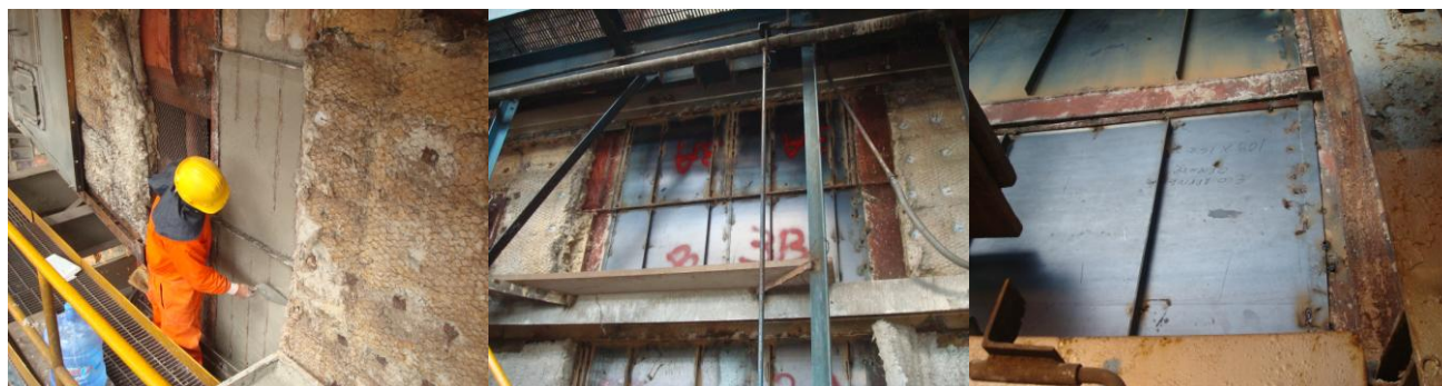
Figura 5.41. Colocación de cemento, colcha de lana y lámina de vista.
