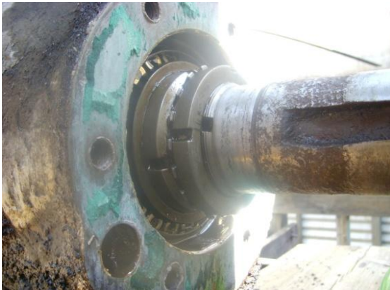
Figura 4.25. Desacoplamiento del reductor.
