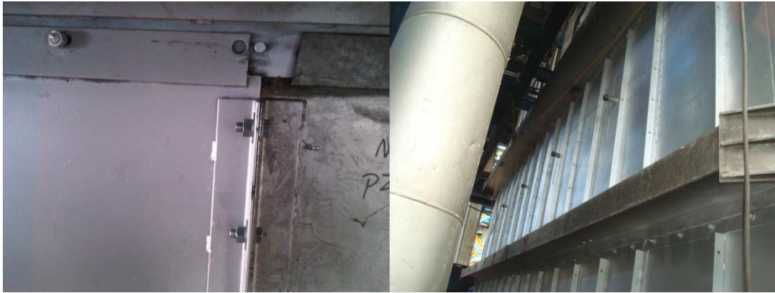
Figura 5.30. Colocación de lámina de vista.
