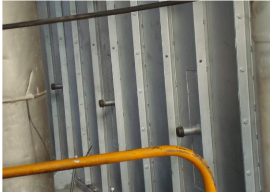
Figura 5.15. Colocación de la lámina de vista.
