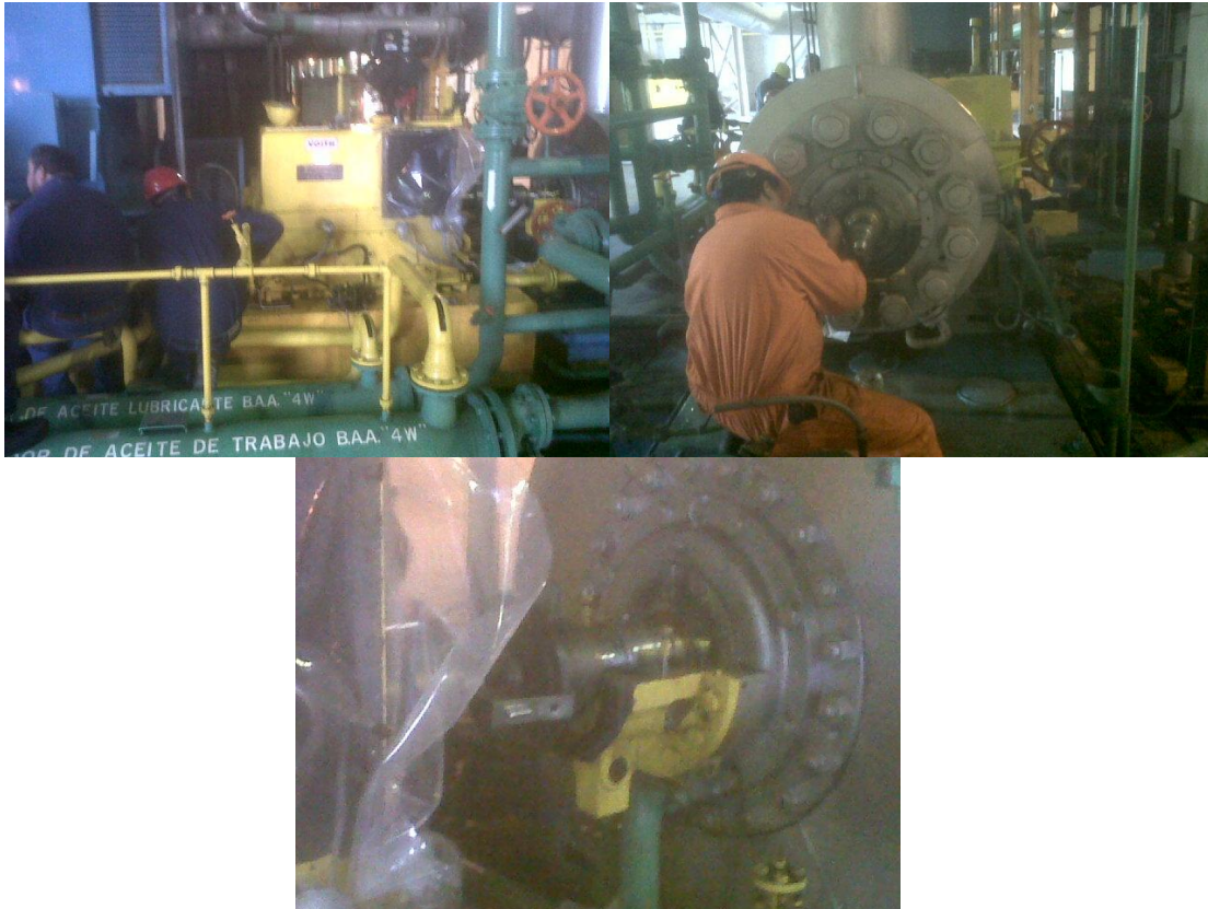
Figura 6.5. Mantenimiento correctivo por parte de Voith.
