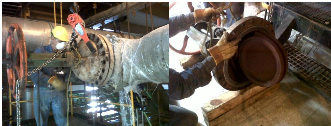
Figura 4.11. Desmontaje de las válvulas de succión B.A.A.
