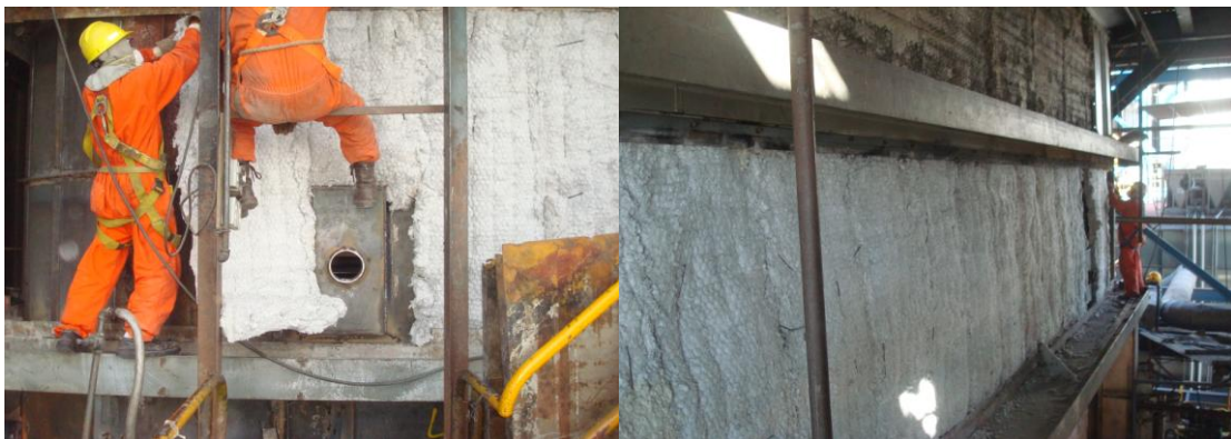
Figura 5.29. Colocación de colcha de lana mineral.
