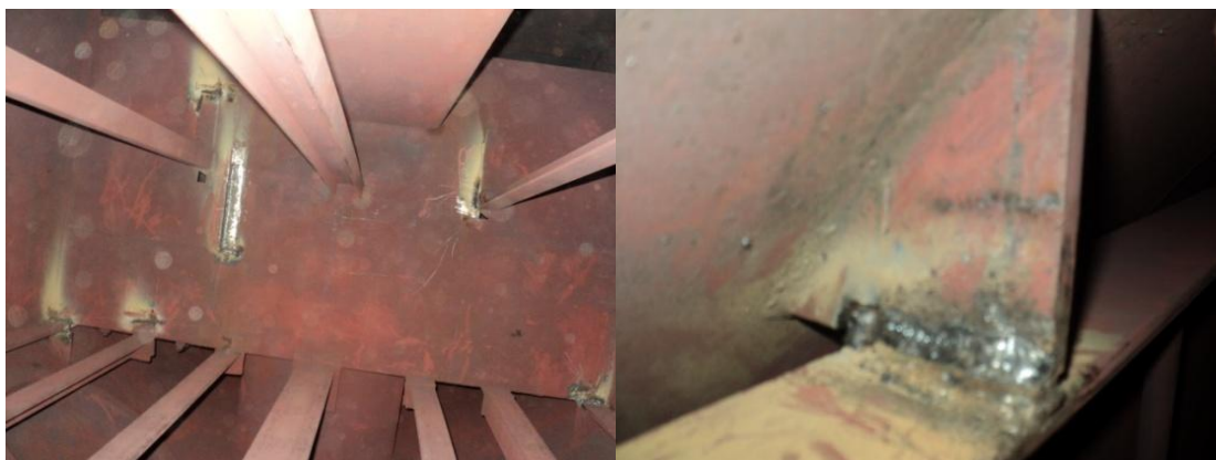
Figura 4.15. Reparaciones en estructura principal del deareador .
