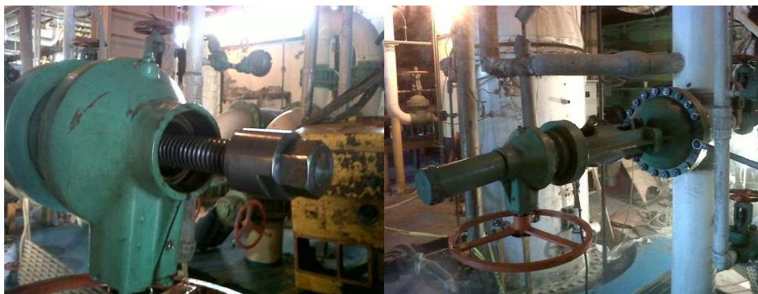
Figura 4.21. Limpieza de vástagos.
