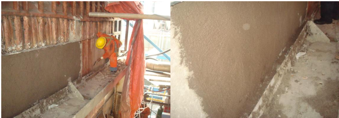
Figura 5.27. Colocación del cemento refractario.
